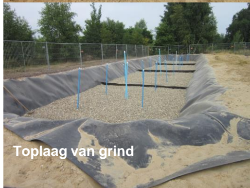
Aanbrengen folie en drainage
