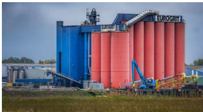
▲ Werk op de Afsluitdijk, aan de Willemsbrug in Rotterdam en de Nijkerkerbrug in Nijkerk is al stilgelegd na de ontdekking van het asbest in het straalgrit. © Qphoto
