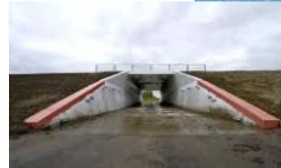
Onder wegen, viaducten
